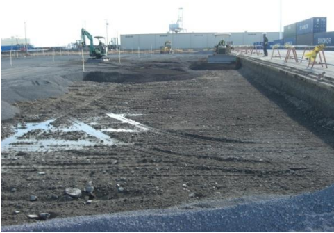
〈製鋼スラグ改良材納入状況〉
