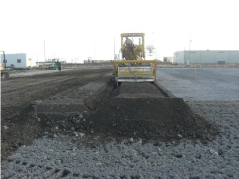
〈スタビライザーによる混合攪拌〉
