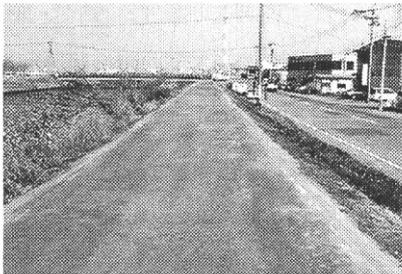
舗装材は、高炉水砕スラグと製鋼スラグを独自配合したもの。水分や炭酸ガスなどによって粒子間をつなぐとともに、空隙を満たして固まる。施工は、舗装材を敷いた後に散水と転圧、1週間程度の養生で完了となる。
